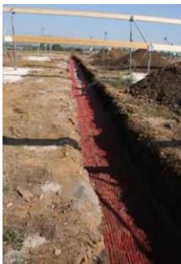
Ouverture d'une tranchée pour l'enfouissement des câbles © Ministère de l'écologie
